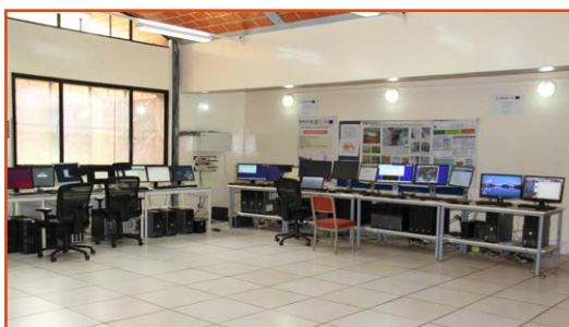
Salle des télécommunications totalement réhabilitée avec extension et partiellement équipée
