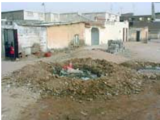
Photo 2 : Pendage des eaux usées dans les crevasses au milieu de la rue : A ancienne crevasse en voie d'enterrement, B nouvelle crevasse engorgée
